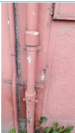
Matériaux : ZPSO-083 Prélèvement : P082 Description : Conduit de ventilation Localisation : Façade Résultat : Présence d'amiante
